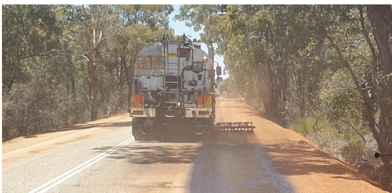
Edge break sealing
